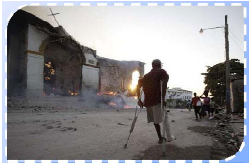
Santuário de Nossa Senhora do Perpétuo Socorro, depois do terremoto de 12 de janeiro de 2010.
